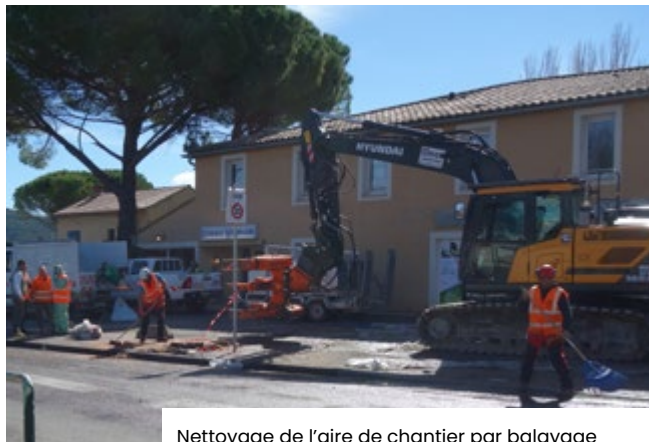
Nettoyage de l'aire de chantier par balayage et ramassage des bâches, Vaison-la-Romaine, mars 2023 | © Plante & Cité / Marine de Bodard
