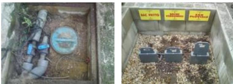
Deux exutoires avec un seul bouchon. Chaque exutoire est relié à un circuit indépendant. Le bouchon permet d'obstruer l'une ou l'autre des évacuations selon l'utilisation de la plateforme
